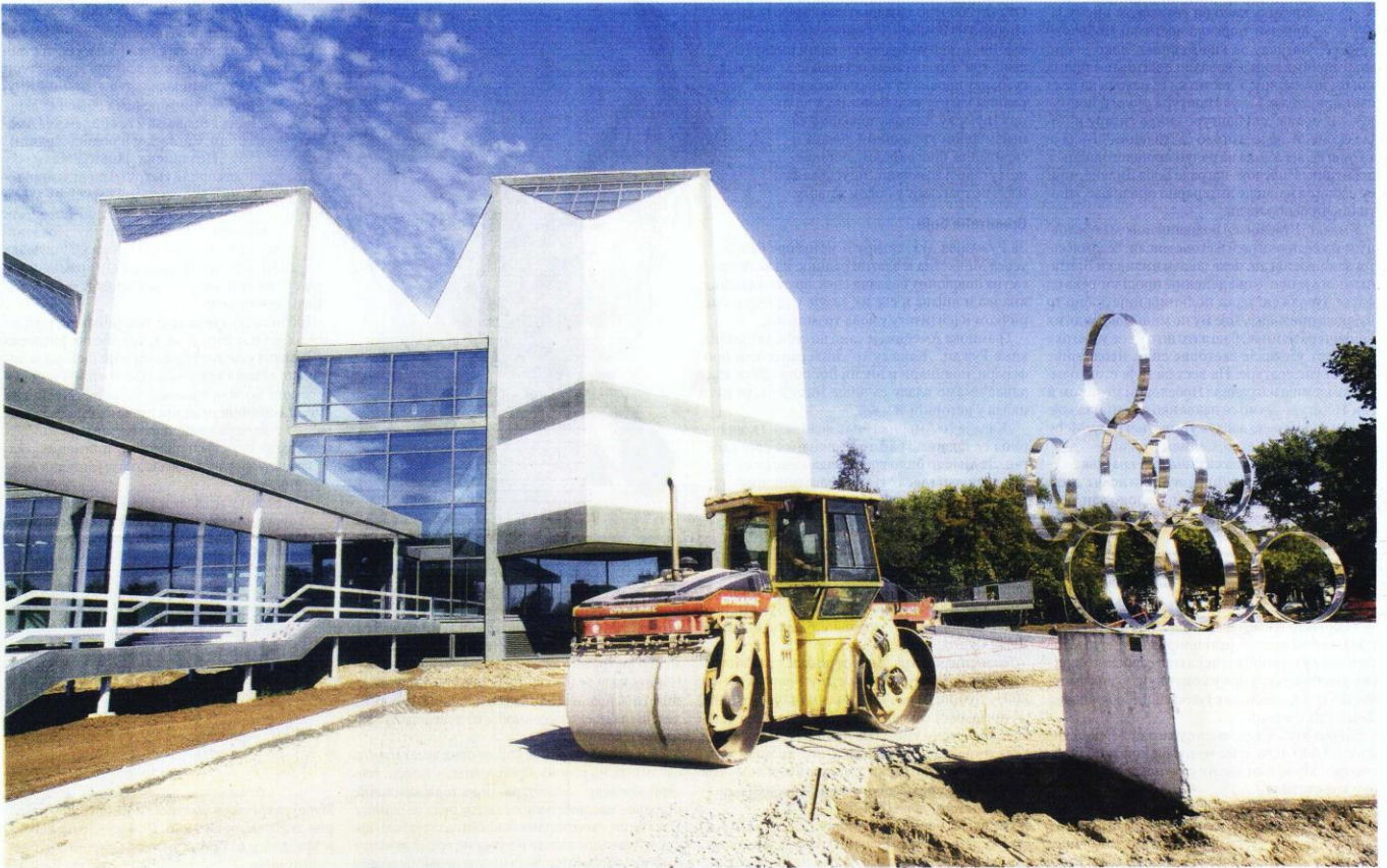
Окупана фасада Музеја савремене уметности у Београду: у збирци више од 8000 дела Фото Аиђелко Васиљевић
